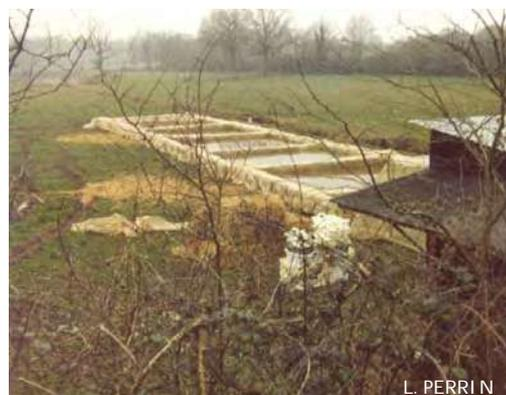
**Figure 3 : Installations de bac de stockage avec bottes de paille, bâches plastique et filet brise vent**
