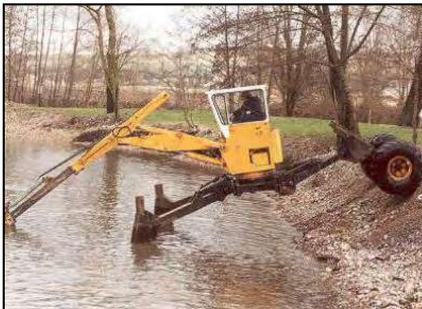
**Photographie 1 : curage d'un plan d'eau par une pelleuse**
