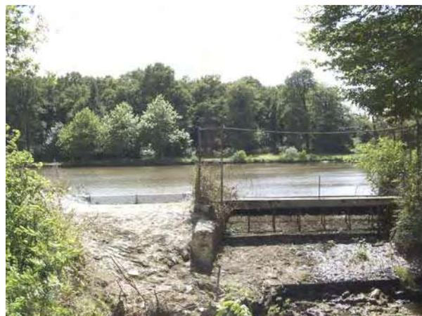
**Figure 4 : photo d'un déversoir comprenant 2 parties, la plus basse jouant le rôle de surverse.**
