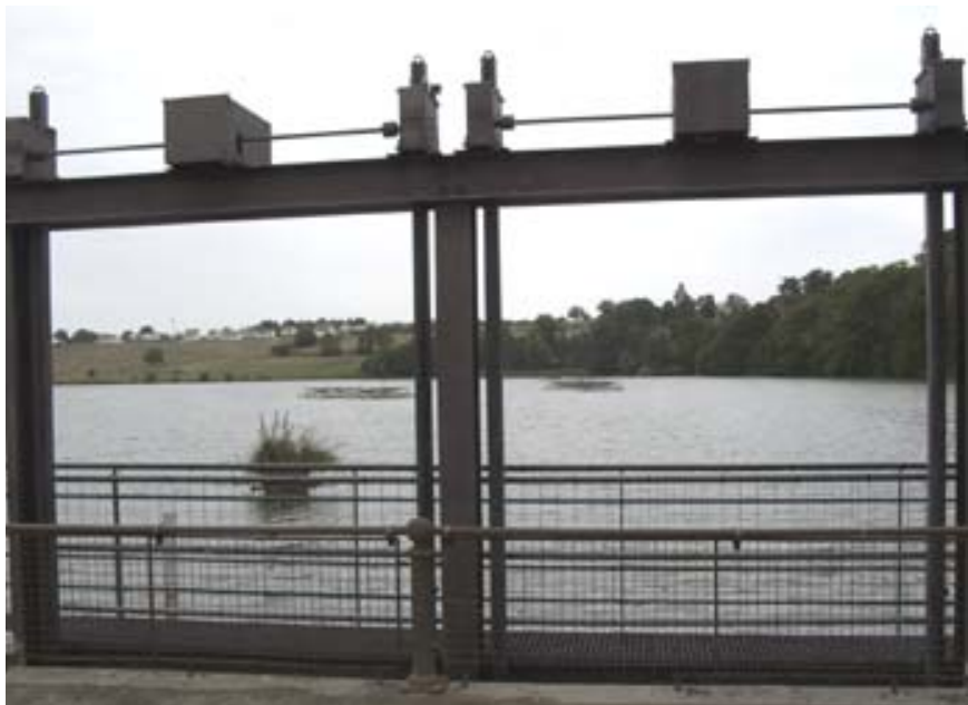
Figure 5 : Etang de la Forge et l'aménagement de nouveaux ouvrages hydrauliques.
