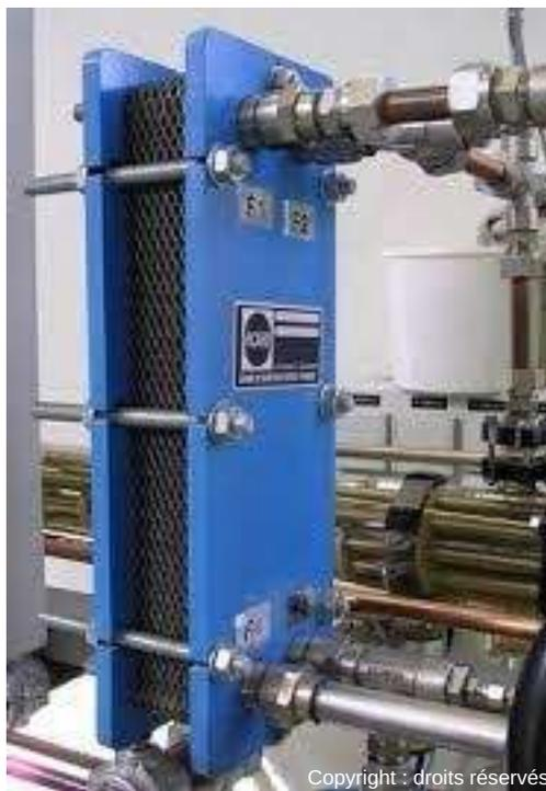
Exemple d'échangeur à plaques (eau-eau)
