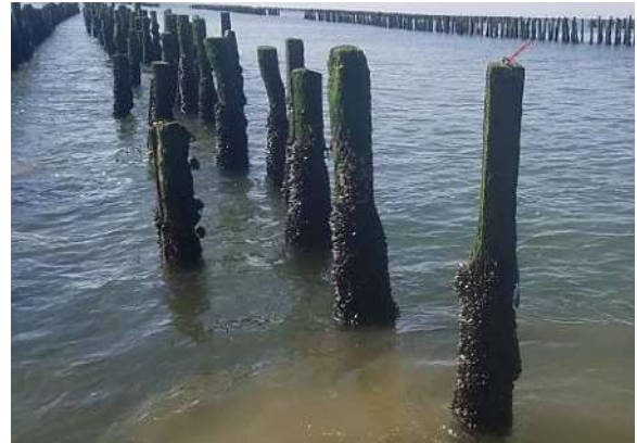
Figure 12 : Vue des pieux catinés avec des filets chaînette Ponsa. En 6 mois et demi, aucune casse de maille n'est constatée sur ces filets (Site de Kervoyal 1)
