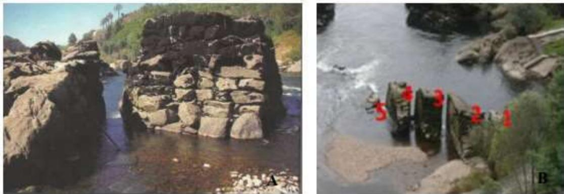
Figure 48 : (A) La structure des Pesqueira, faite de roche, créant un canal entre les deux, où les engins sont placés pour capturer les espèces anadromes (Leite, 1999). (B) La structure Pesqueira est composée de cinq blocs de roches (Pacheco, 2013)
