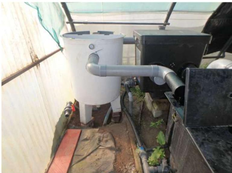
Ainsi, ce décanteur limite les pertes en eau et permet également de récupérer de nombreuses MES riches en phosphate et en azote. C'est un cylindre conique, constitué de deux parties séparées par une planche horizontale percée au fond, qui permet de favoriser la décantation des boues au fond du cylindre et d'en faciliter la récupération. Ensuite, La partie liquide « propre » issue du filtre à tambour est redirigée vers le filtre biologique (figure 21).
