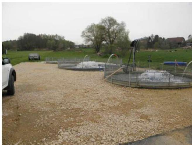
Figure 48 : bassins de stockage équipés d'aérateurs, à proximité d'un atelier de transformation implanté en Alsace
