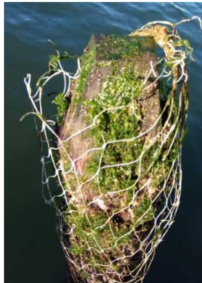
Figure 20: casse importante, déchirures compromettant la fonctionnalité du filet,
