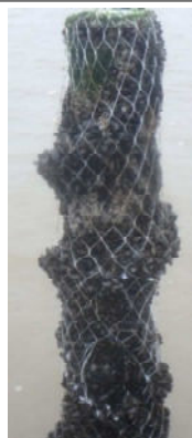
Figure 22: Filet endommagé Ecoplas toujours fonctionnel, site de Banc du Nord, 24/01/2020
